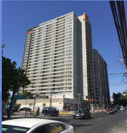
OBRA EDIFICIO Ecuador II Ubicación: Estación central
