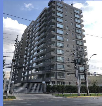
OBRA EDIFICIO TEMPUS Ubicación : San Miguel, RM.
