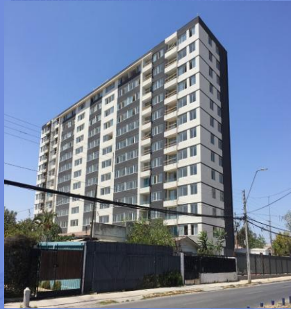
OBRA EDIFICIO BARCELONA Ubicación : La Cisterna, RM.
